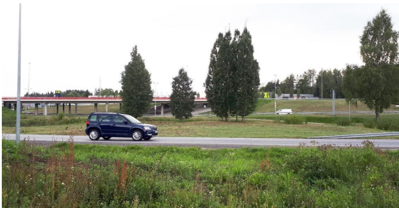
Kuva 9 Vanhan Viipuritien ja Valtatie 6:n liittymäalue. Edustalla Vanhalle Viipuritielle johtava ramppi.
